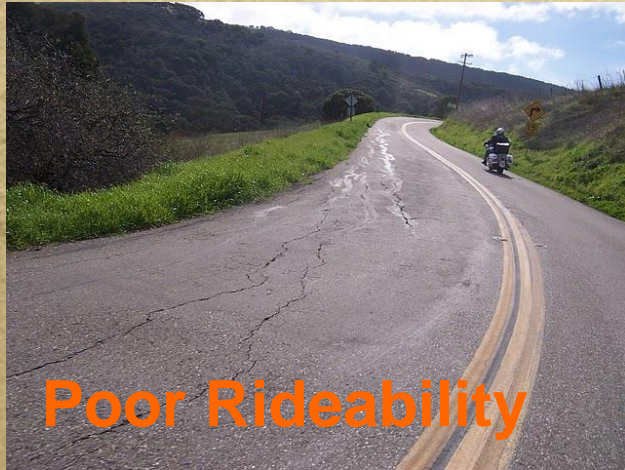
Thermal Cracking
