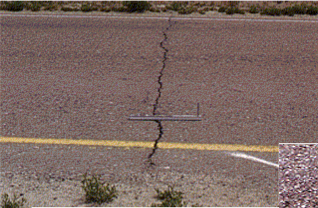
Thermal Cracking
